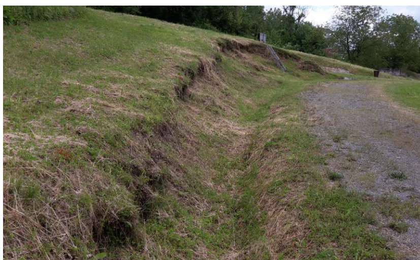
Sl. 1.3. Fotografija pokosa i odvodnog kanala
